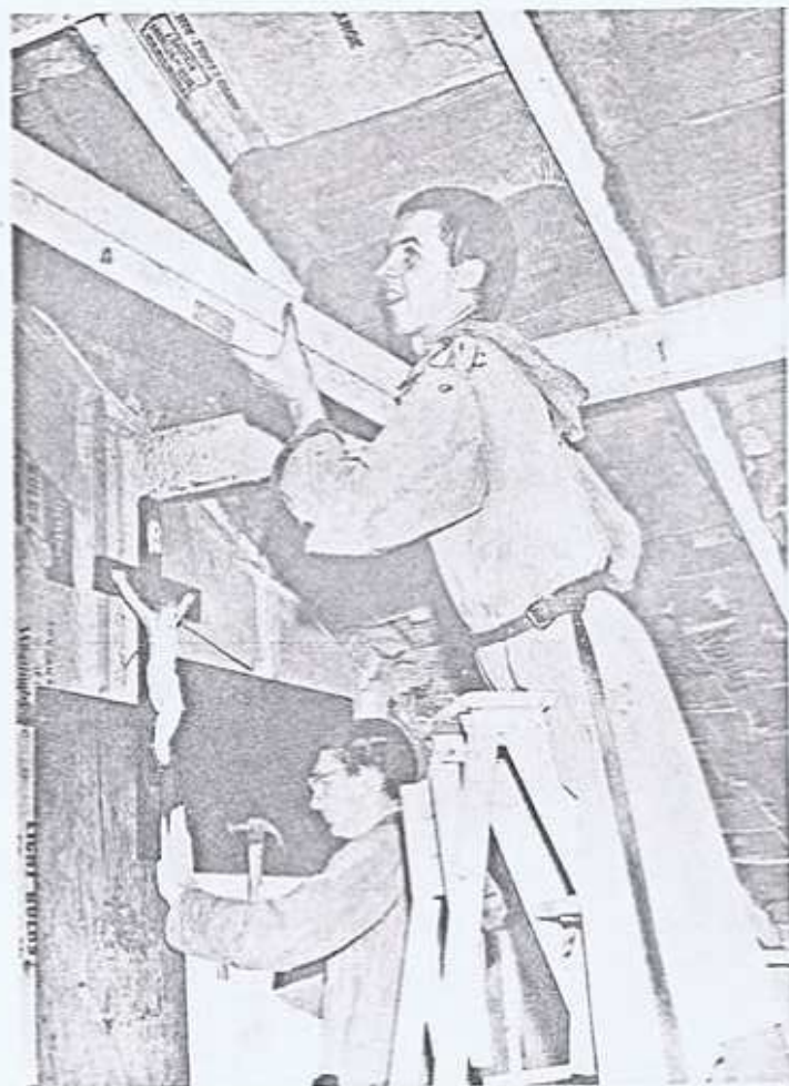
Building the 'casa abaziale'
